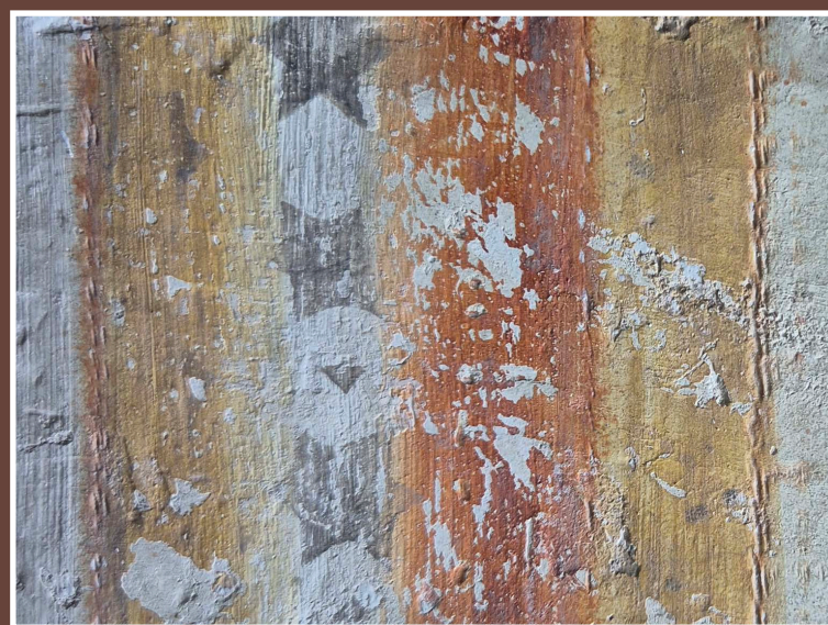
Sl. 10 Detalj bordure s vidljivim ipucanim konopom
