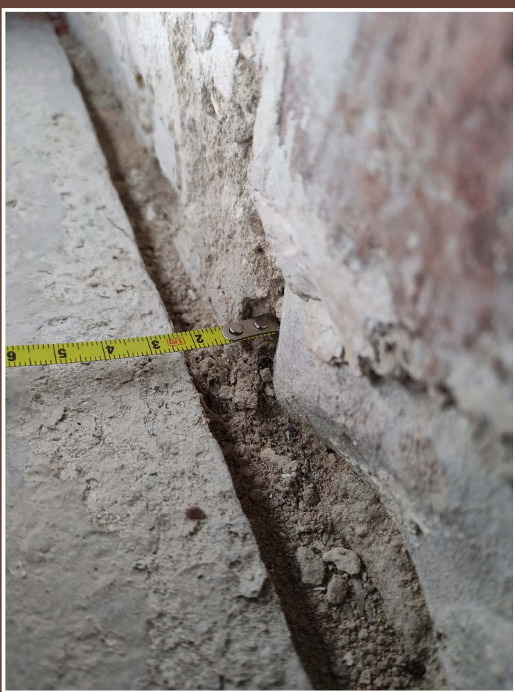
Sl. 8 Mjerenje debljine žbuke
