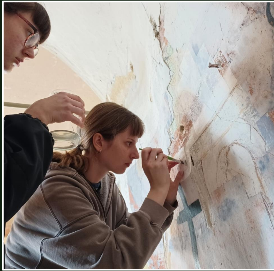
Sl. 13. Privremeno učvršćivanje nestabilne srednjovjekovne žbuke japanskim papirom i 1,5%-tnom otopinom Tylose MH300.
