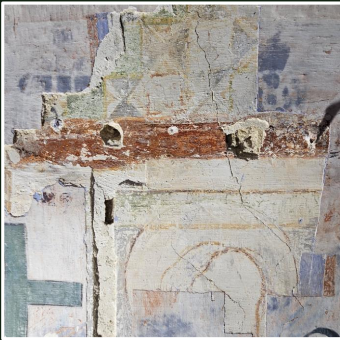
Odvajanje žbukanih slojeva.
